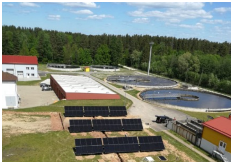
Bioloģiskajās notekūdeņu attīrīšanas iekārtās Valmierā uzstādīti saules paneļi. Foto: SIA “Valmieras ūdens”
