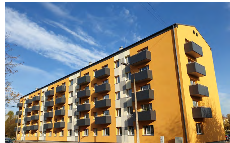
Atjaunota un energoefektīvāka daudzdzīvokļu ēka Valkas novadā Stendera ielā 2. Foto: facebook.com/dzivosiltak
